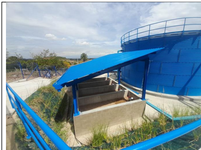
Foto 3. Lechos de secado y tanque de almacenamiento
